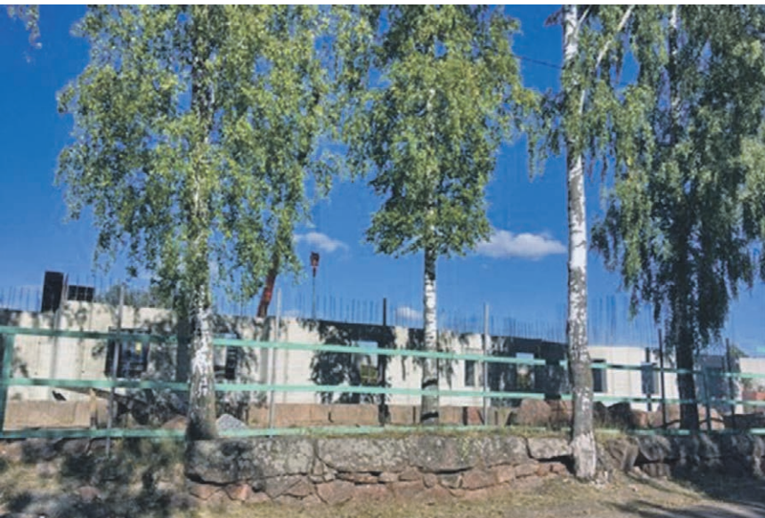
Edellisvuoden kuva rakennuksen alkaessa nousta.
